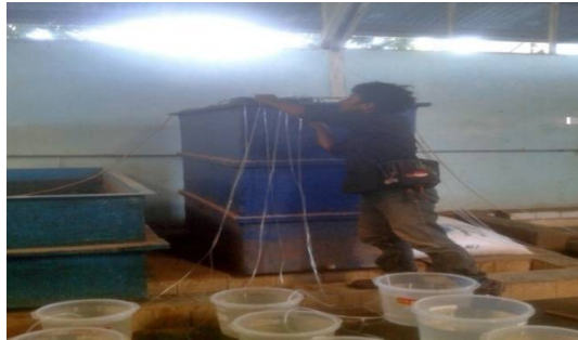
Memasang kelengkapan aerasi
