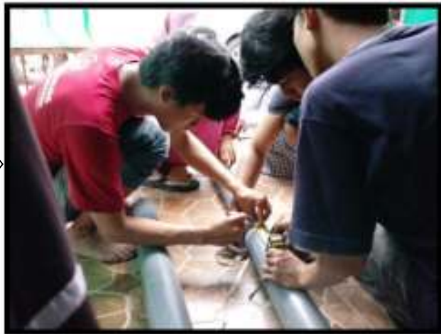
Gambar 2. Pengukuran spasi lubang flushing conduit
