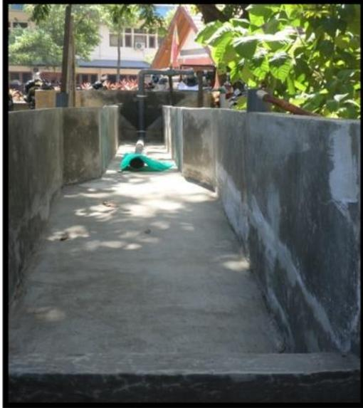
Gambar 4. Model Saluran *flushing conduit*
