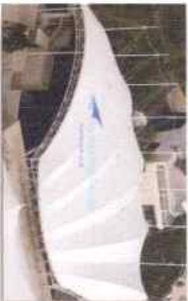
Struktur atas menggunakan struktur kabel dengan atap kain membran pada bagian yang memerlukan bentangan lebar seperti auditorium, exhibition hall dan atrium. Sedangkan pada massa bangunan yang tidak terlalu lebar menggunakan struktur atap beton
