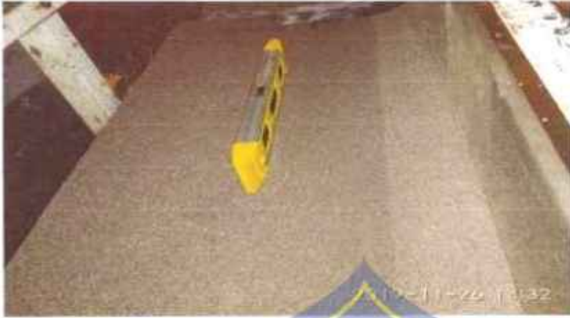
Gambar : Mengukur kesejajaran pasir meggunakan waterpas
