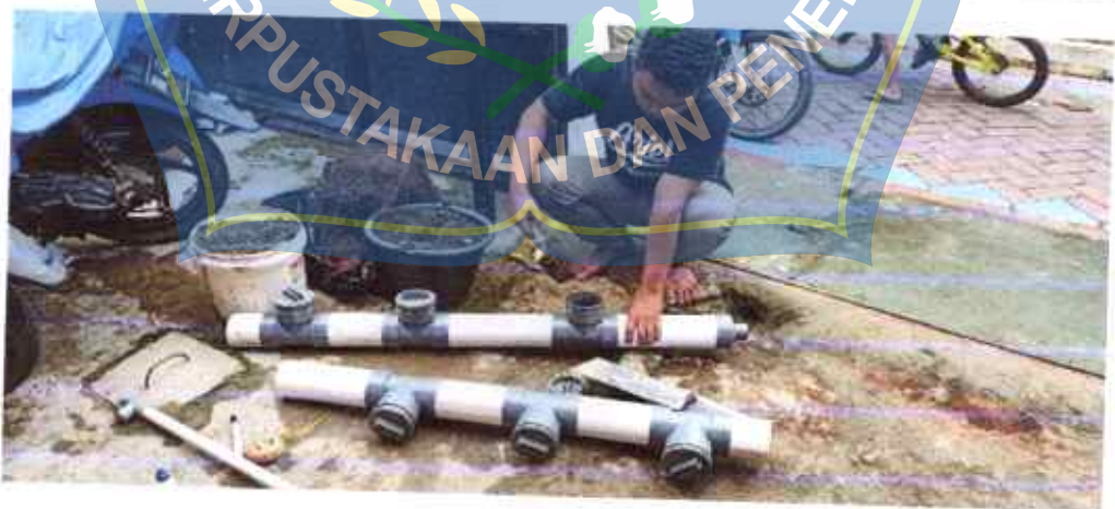
(Proses pengisian material saringan di dalam pipa)
