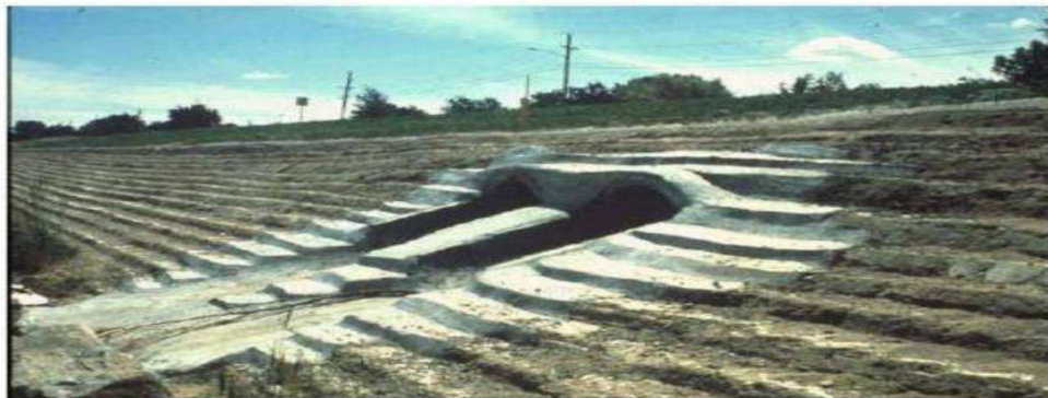
Gambar 10. Pelindung tebing sungai dengan metode campuran semen tanah (rezkiana, 2011).
