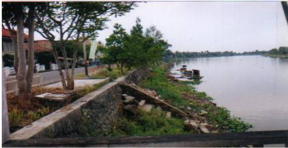
Gambar 12. Pelindung sungai dengan metode turap batu kali (Rezkiiana,2011)
