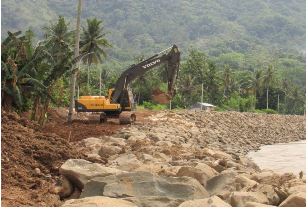
Gambar 7. Pelindung tebing sungai dengan metode pasangan batu (lokasi sungai Mata Allo, 2016)
