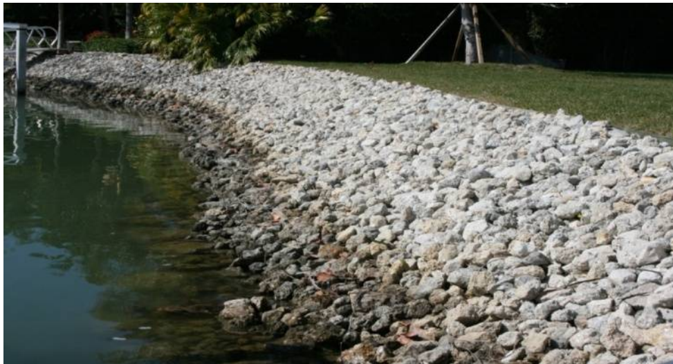
Gambar 9. Riprap sebagai pelindung tebing sungai (marine construction 2011)
