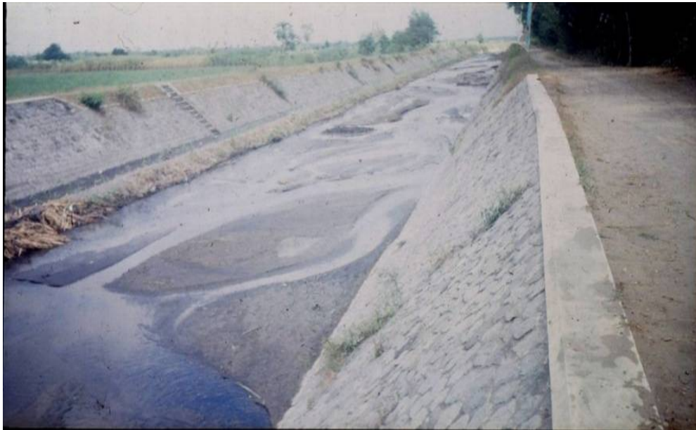
Gambar 8. Pelindung tebing sungai dengan metode perkerasan dengan beton.
