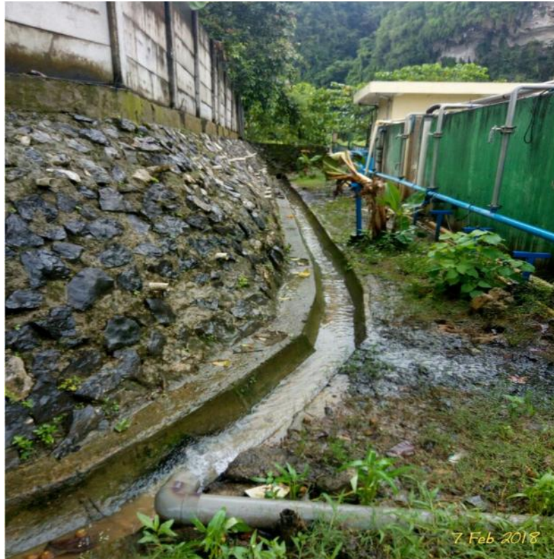
Gambar: instalansi pipa effluem/pipa pembuangan dari bak kontrol
