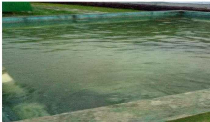
Gambar: Bak equalisasi tempat penampung yang mengandung nutrisi atau pupuk.
