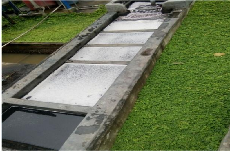
Gambar : Oxidation ditahap 1 tempat penampungan sementara yang mengandung pupuk dan sudah ada lumpur active dengan alat pengaduk airator/ motor besar.
