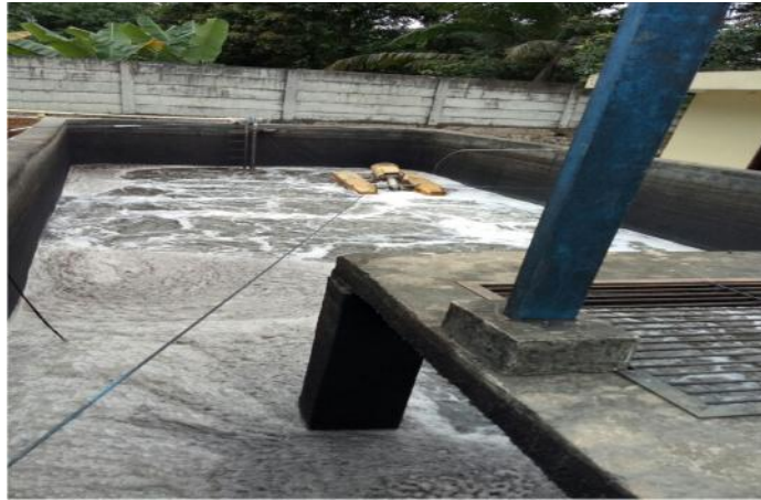
Gambar: Bak kontrol hasil akhir yang sudah bisa dibuang langsung kelingkungan.
