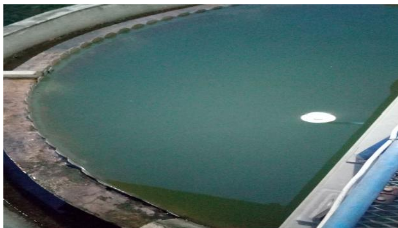
Gambar: Clarifear 3 memisahkan lumpur dan air yang dimna mengandung pac.
