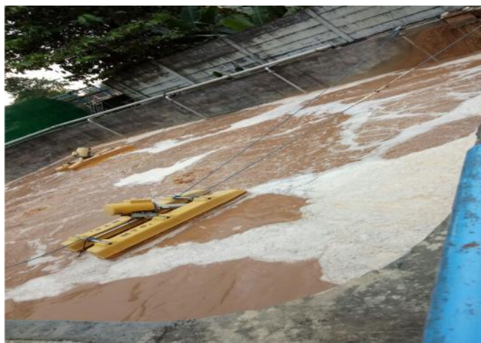
Gambar: Bak equalisasi tempat penampung yang mengandung nutrisi atau pupuk.
