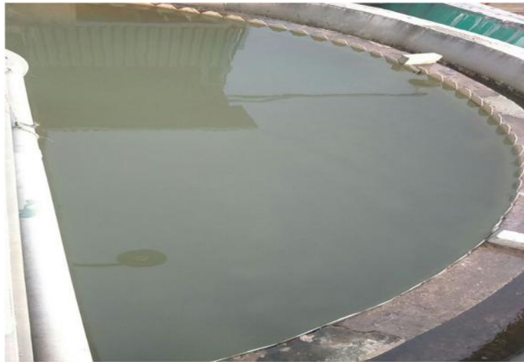
Gambar: Calarifaer 1 untuk memisahkan air dan lumpur dari oxidation ditahap 1 lalu suplai bening ke oxidation ditahap 2.
