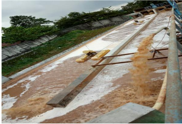
Gambar: Calarifaer 1 untuk memisahkan air dan lumpur dari oxidation ditahap 1 lalu suplai bening ke oxidation ditahap 2.
