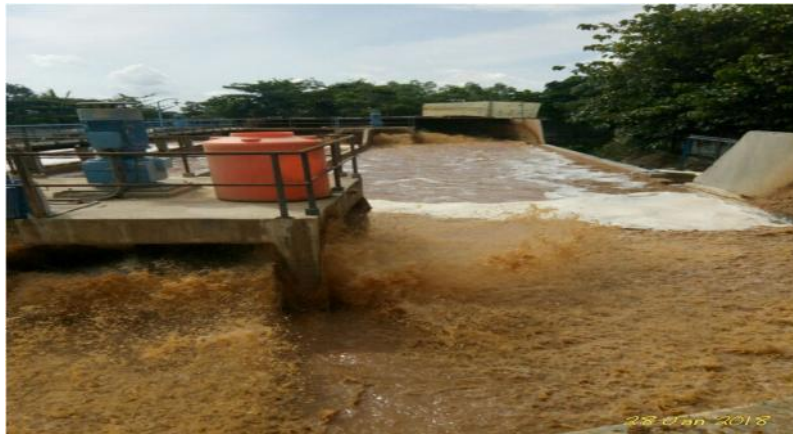
Gambar: Clarifear 3 memisahkan lumpur dan air yang dimna mengandung pac.
