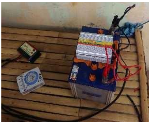
Lokasi Penempatan Panel Daya
