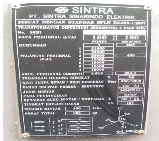
Gambar 3.1 spesifikasi transformator
