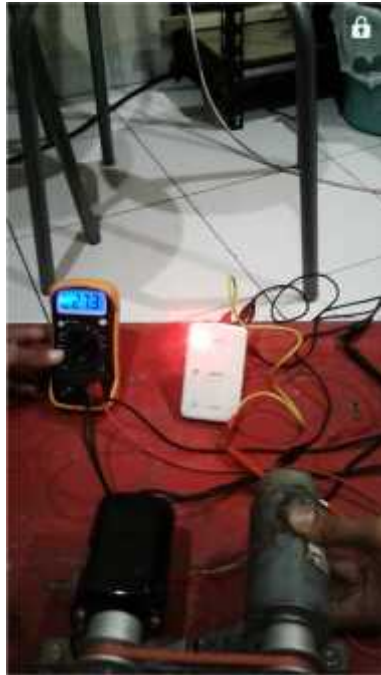
Lampiran 3. Gambar pengukuran tegangan tinggi
