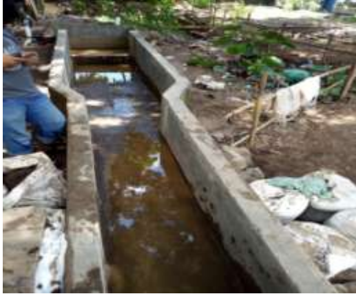
Gambar 4. Model Saluran flushing conduit
