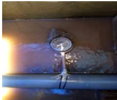
Gambar 5. Pengukuran tekanan menggunakan manometer
