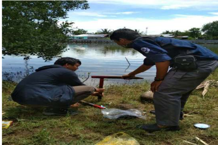
Gambar Pemasangan patok
