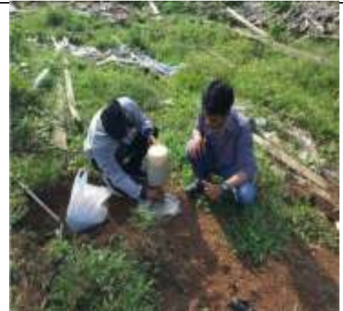
Proses pemasangan Sandcone pada titik lubang
