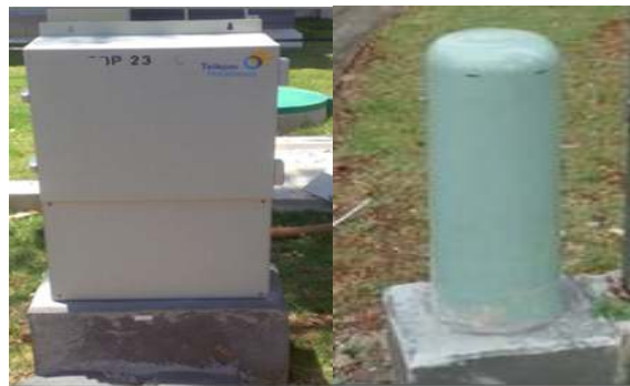
Gambar 2.5 ODP Tipe Pedestal
