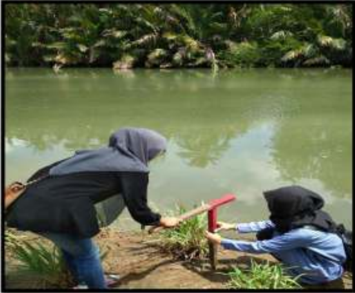
Proses pemasangan patok
