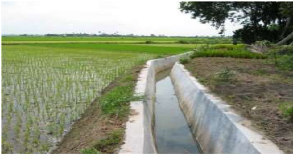
Gambar 3. Saluran Irigasi Tersier
