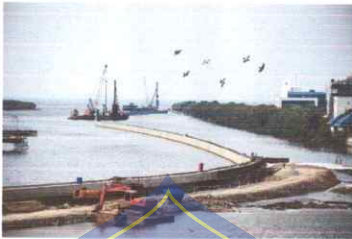
Gambar 16. Contoh tanggul laut (sea dike) pada pantai
