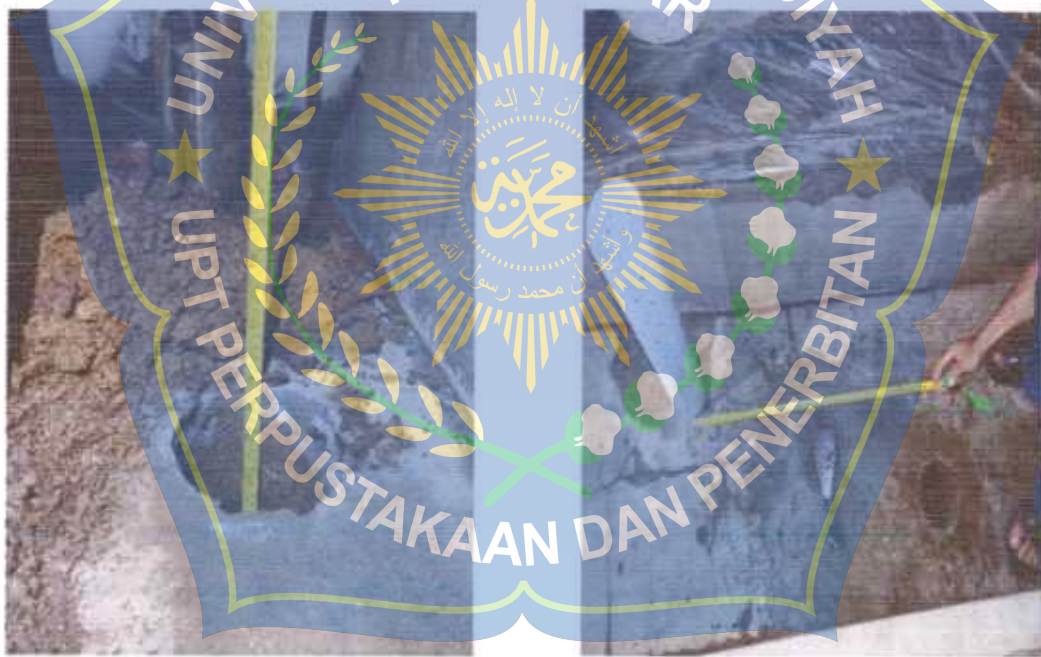
Pengukuran kedalaman lubang biopori 50 cm. Pengukuran jarak antar lubang
