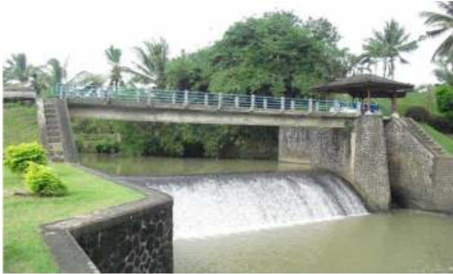
Gambar 1. Bangunan pelimpah tipe ogee
