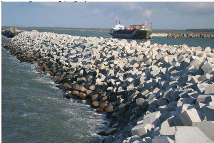
**Gambar 6.** Pemecah gelombang untuk melindungi kapal dari gelombang
