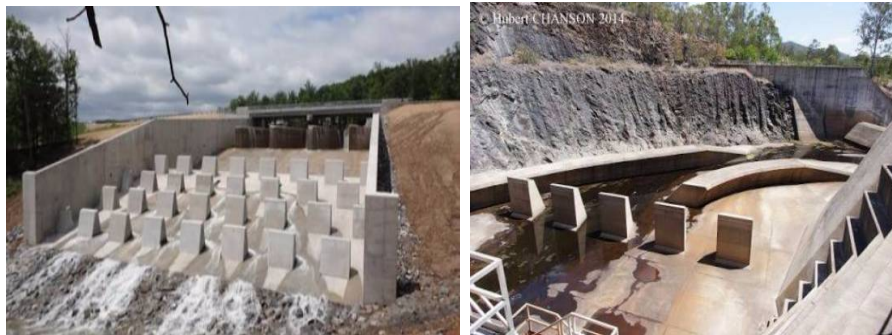
Gambar 8 . Pemasangan Baffle Blocks (Hubert Chanson 2014)
