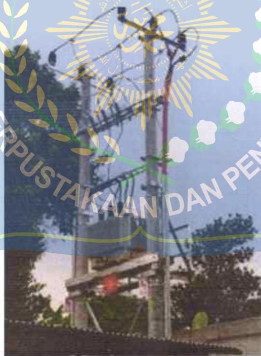
Gambar 2.2 Saluran Udara Tegangan Menengah (SUTM) (PT. PLN (Persero)Buku5, 2010)
