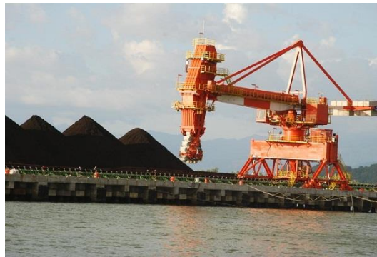
Gambar 4.10. Coal Unloading Pelabuhan Biringkassi
