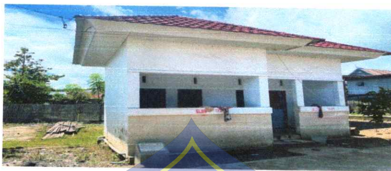
Gambar 15 (Fasilitas Wc Umum)
