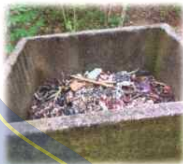
Bak pembakaran sampah
