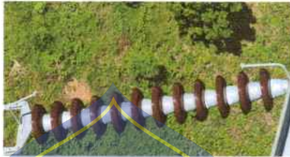
Gambar 2. 7 Arching Horn pada Isolator Tension
