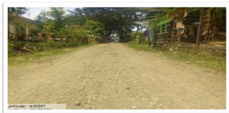
Foto 0% Jalan Paving Blok 80 M
