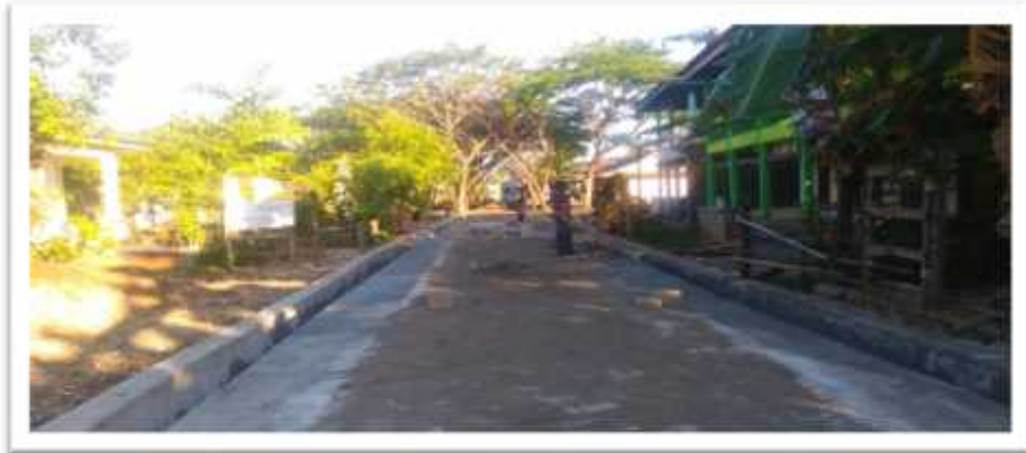
Foto 75% Jalan Paving Blok 80 M
