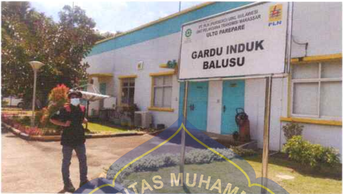
Gedung Pengontrolan Gardu Induk Balusu (PLTU Barru)
