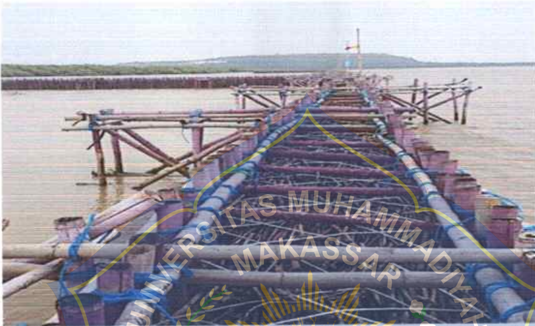
Gambar 12. Proses Struktur HE yang sudah selesai dan siap digunakan (Sumber Gambar: Ecoshape Consortium , 2016)
