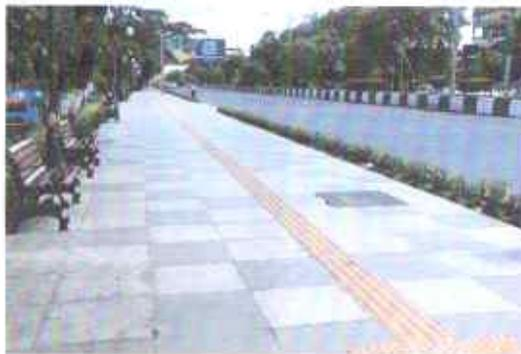
**Gambar 52.** *Guiding Block* atau Jalur Penuntun
