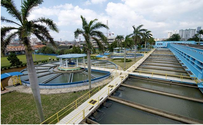
Gambar 9.2. Meningkatkan Sanitasi Lingkungan, Yogyakarta menambah Instalasi Pengolahan Air Limbah
