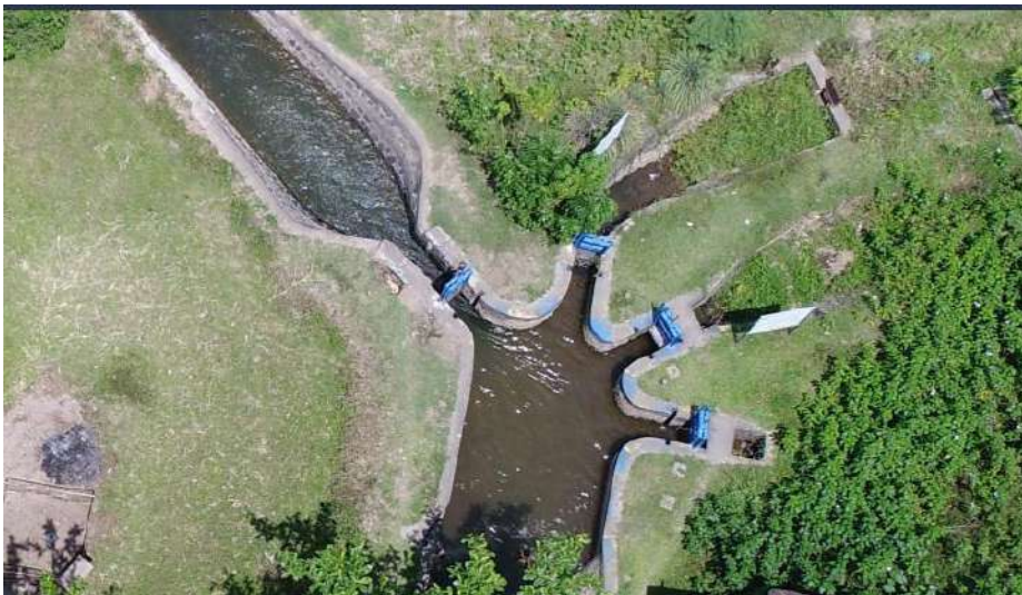
Gambar 15. Pintu Tersier yang Diperoleh dari Saluran Sekunder yang Membagi ke Saluran Tersier
