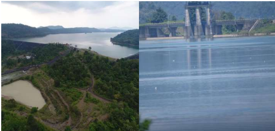
Gambar 6. Dam Bili-Bili di Kabupaten Gowa, 2016
