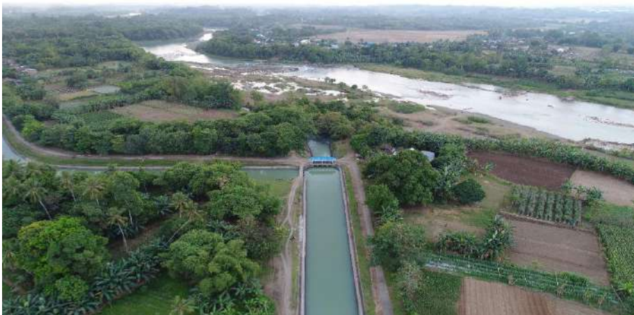
Gambar 8. Pintu Pembuang, Penguras Lumpur dan Pintu Saluran Induk (Primer) Daerah Irigasi Kampili
