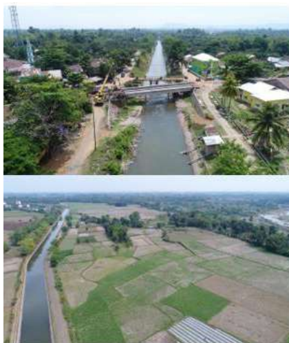
Gambar 9. Saluran Induk (primer) pada wilayah Hulu Daerah Irigasi Kampili
