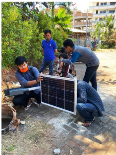
Gambar 3. Pemasangan sel panel surya
