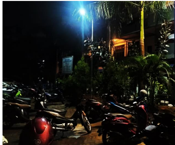
Gambar 4: Lampu Panel Tenaga Surya di Malam Hari
