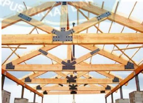
**Gambar 41** Struktur Rangka Atap Kayu
