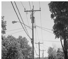
Gambar 1 Saluran Udara Tegangan Menengah (SUTM)
