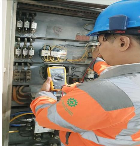
Gambar 4.18 Pengujian tegangan *relay* pada saat *aktif*
