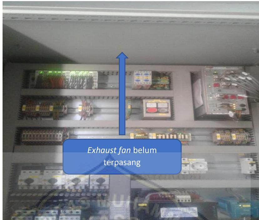
Gambar 4.2 *Exhaust fan* belum terpasang
