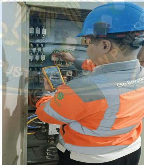
Gambar 4.17 Pengujian tegangan *relay* pada saat *non aktif*
