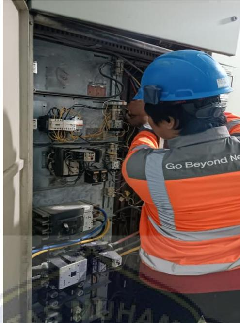
Gambar 4.4 Pemasangan peralatan daya dan peralatan kontrol
