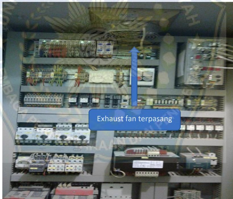
Gambar 4.3 *Exhaust fan* terpasang
