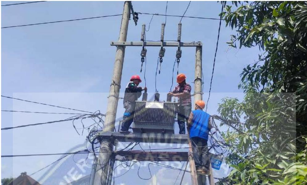
Gambar 3. Penggantian Isolatar yang retak
