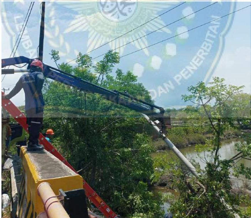
Gambar 4. Penggantian Tiang listrik yang pata
