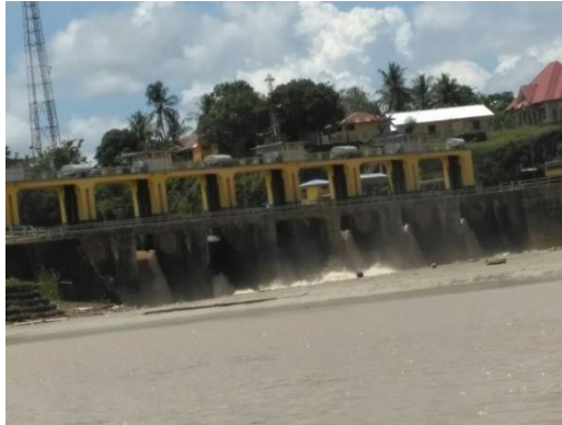
Kondisi hilir bendung benteng pada saat pengambilan sampel sedimen dasar
