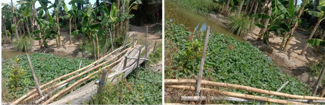
Saluran Drainase di Desa Panakukkang
