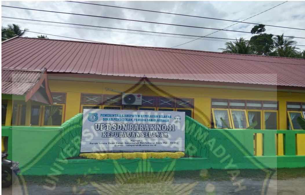
Gambar 1 UPT SDN Parak No. 11 Kepulauan Selaya
