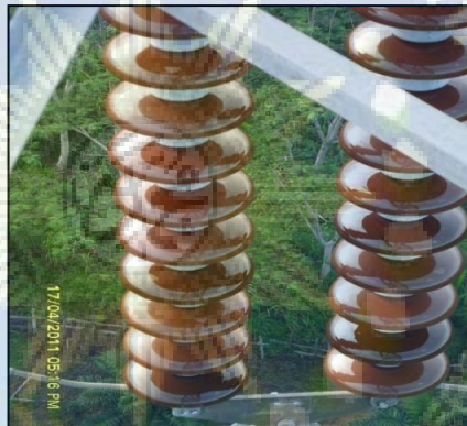
Gambar 2.3 Isolator Keramik (Sumber ULTG Panakkukang)
