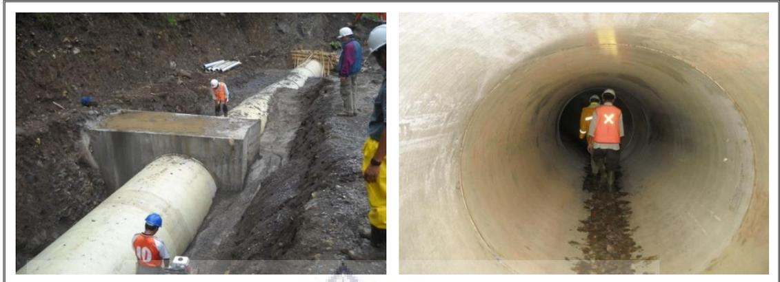
*Gambar 4.4 Kondisi bangunan Pipa Waterway (Saluran Pembawa)*
