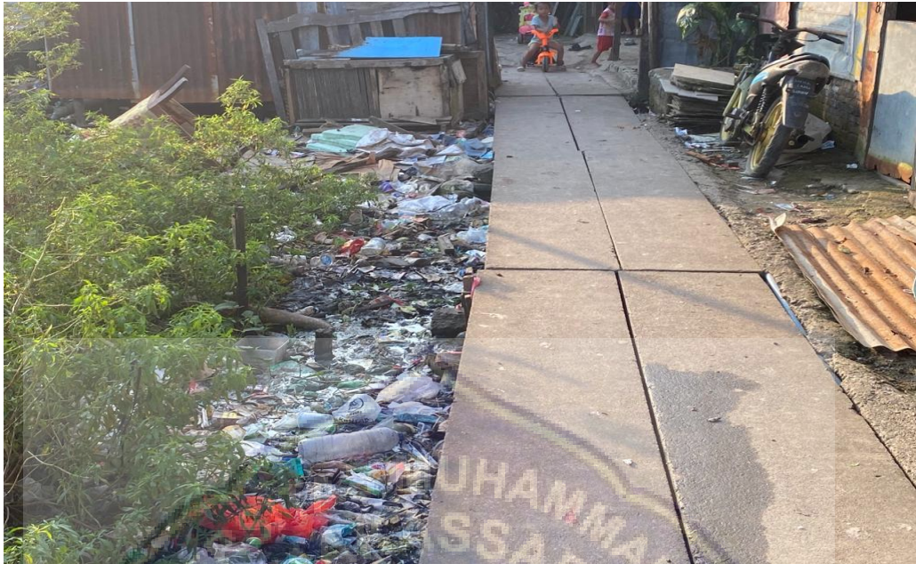
Akses jalanan yang kurang baik
