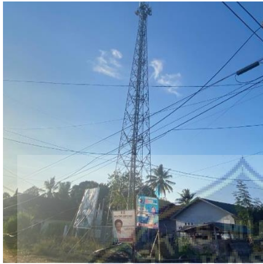
Tower Desa Batang
