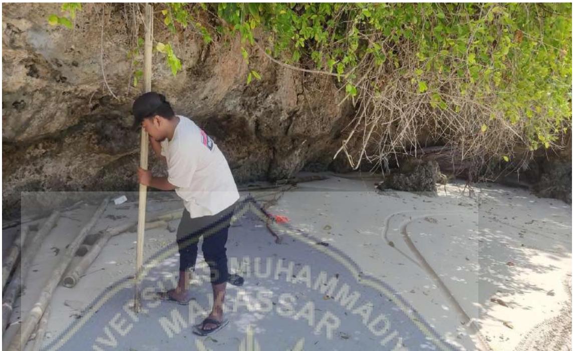
Pemasangan patok pada jarak 1400 meter
