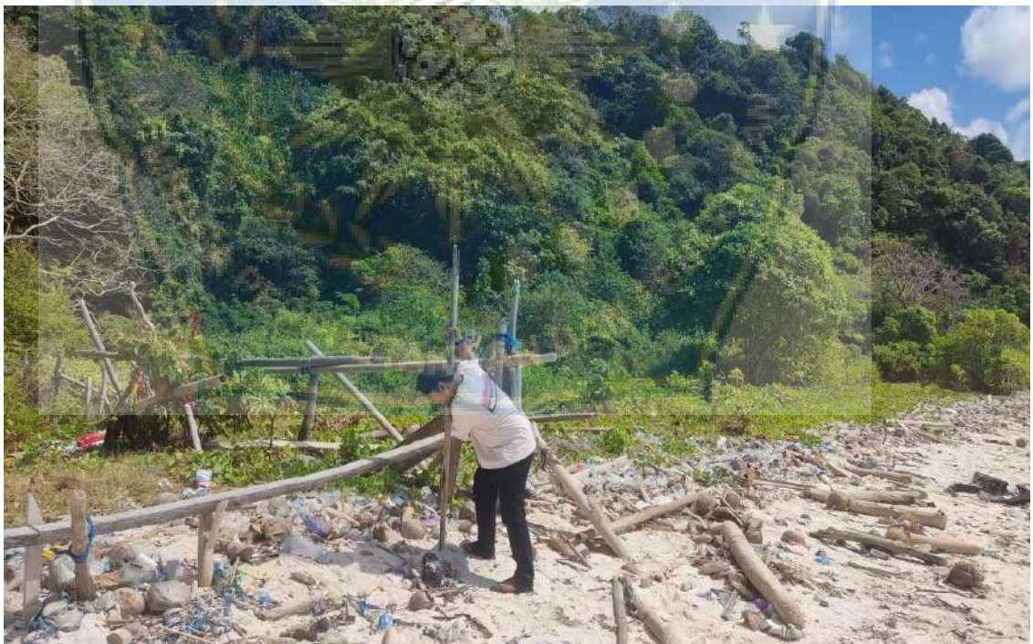
Pemasangan patok pada jarak 960 meter
