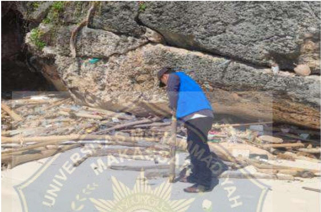
Pemasangan Patok pada Awal Garis Pantai
