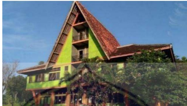
Gambar 2. 12 Sekolah Alam Lampung (sumber: https://sekolah-alam-lampung.business.site/ .2022)
