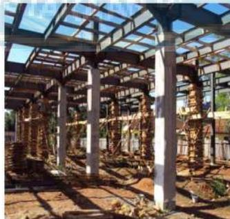
Gambar 3.30 Kolom Dan Balok Baja.
