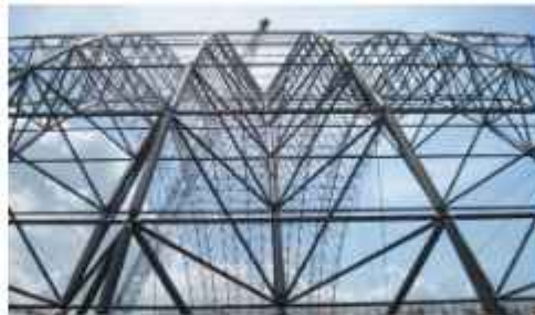
Gambar 35. Struktur Atap Space Frame (Sumber : https://bajaringanvivo.co.id )
