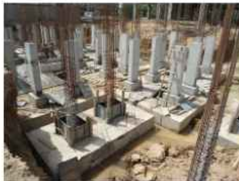
Gambar 33. Pondasi Foot Plat (Sumber : https://blog.rhdesainrumah.com )
